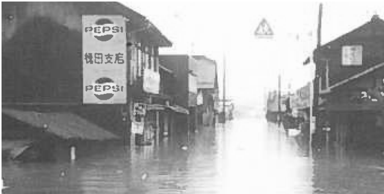
益田市 河川氾濫により浸水した住宅地の様子
