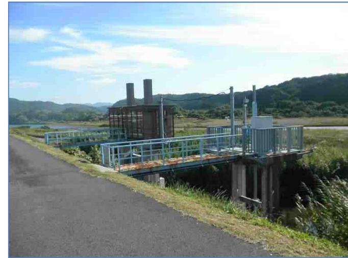
後川第1排水樋門・後川第2排水樋門
