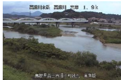
例: 高水敷の冠水
