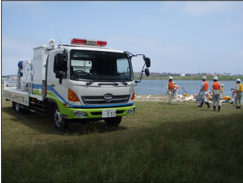
排水ポンプ車排水訓練状況 (平成28年6月、高津川左岸(益田市高津町))
