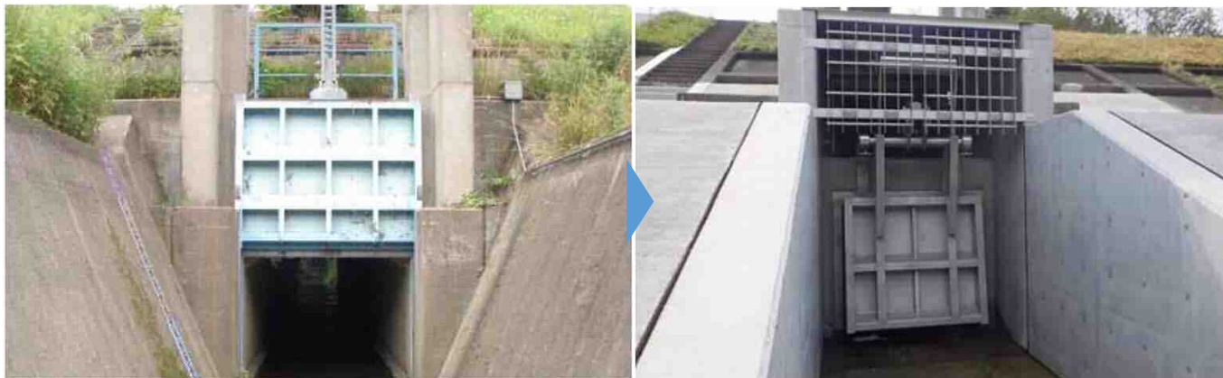
虫追第二排水樋門（左：無動力化前、右：無動力化後）
