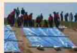
シート張り工
