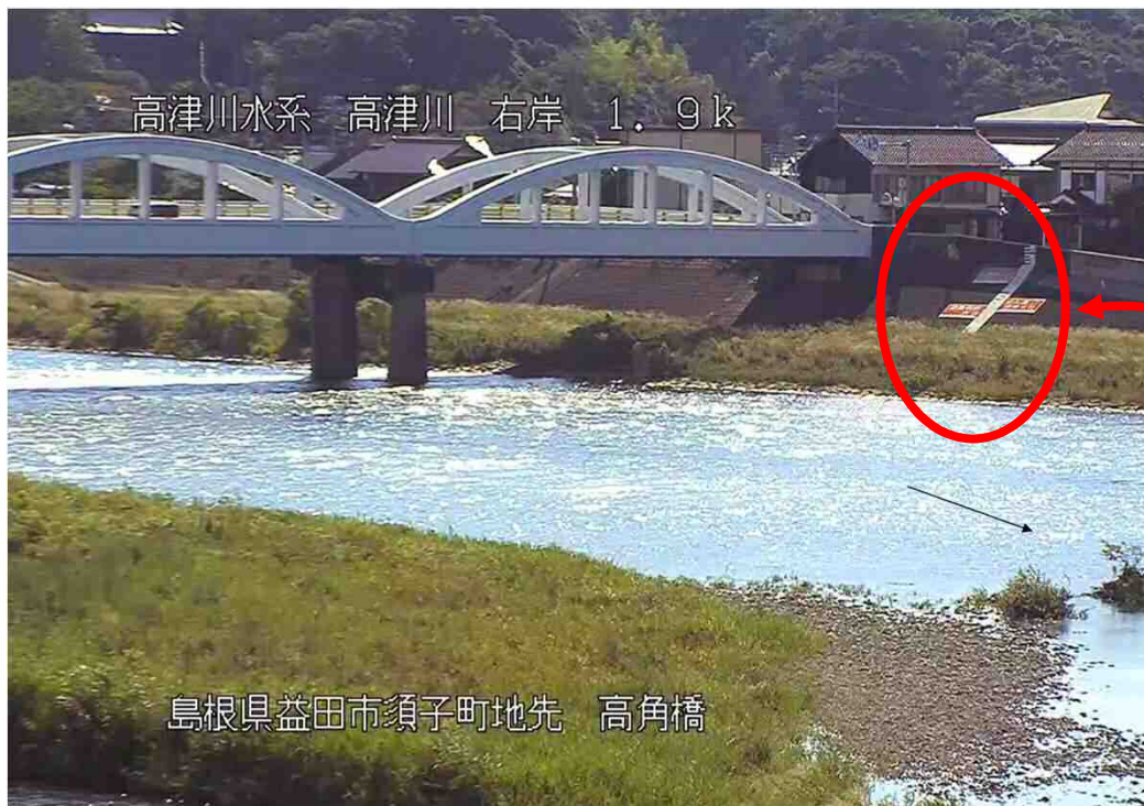
高角橋（高津川）
