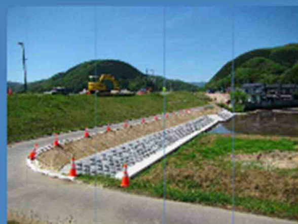
西城川 左岸 寺戸地区 施工状況
