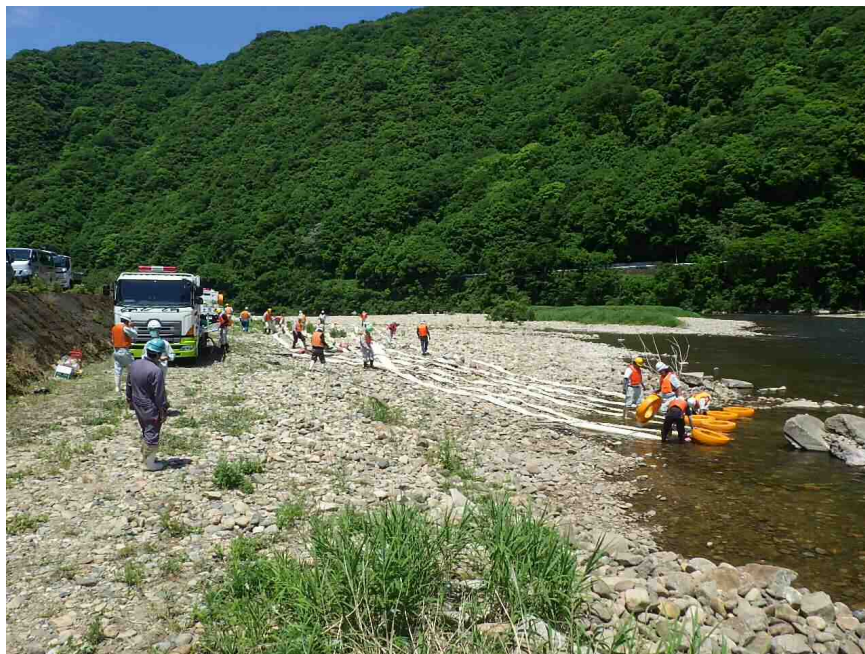
排水ポンプ車設置・操作訓練の様子
