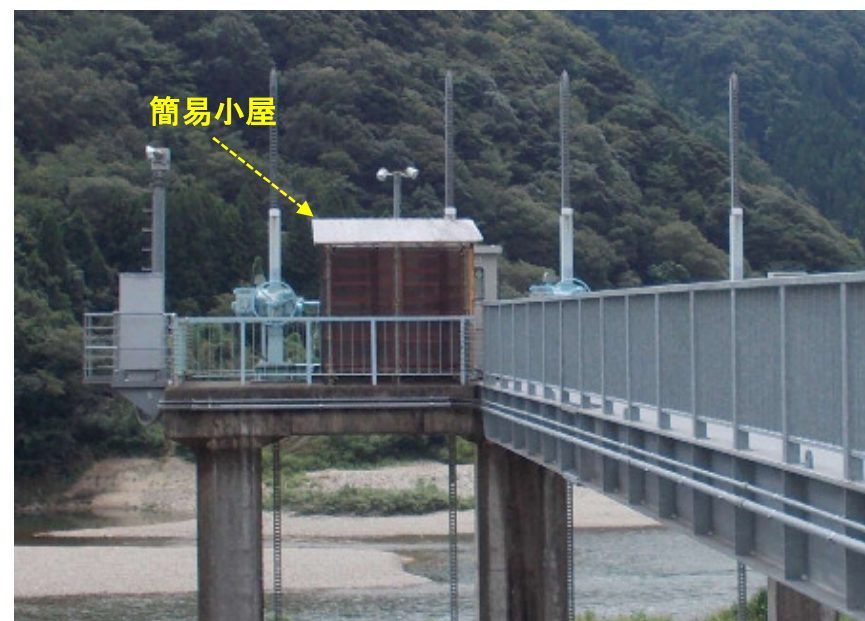
下ノ原排水樋門 簡易小屋
