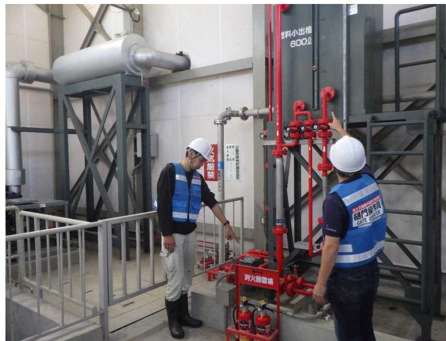
設備点検の様子
