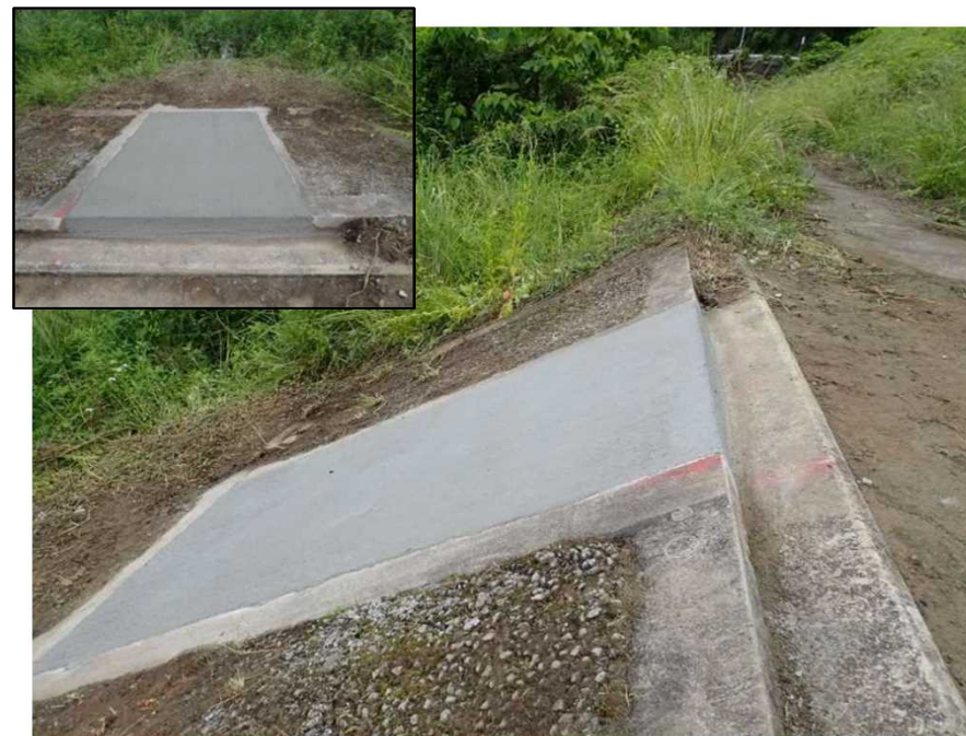
補修後の堤防の様子
