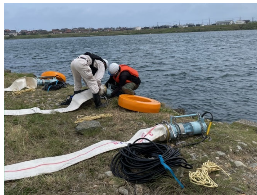
ポンプの吐口を設置する様子
