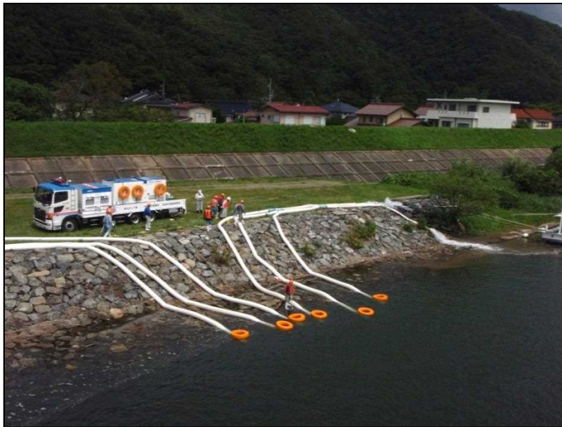
排水ポンプ車排水訓練状況 (平成28年6月、江の川右岸(江津市渡津町))
