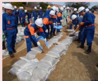
積み土のう工
