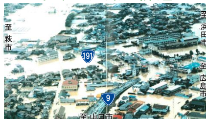
昭和58年7月豪雨の浸水状況
