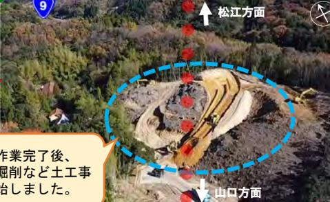
伐採作業完了後、山の掘削など土工を開始しました。
