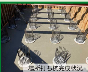
場所打ち杭完成状況
