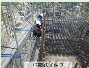
柱部鉄筋組立
