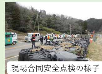
現場合同安全点検の様子
