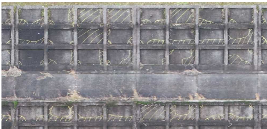
UAV 写真撮影による法枠護岸打音調査結果の整理
