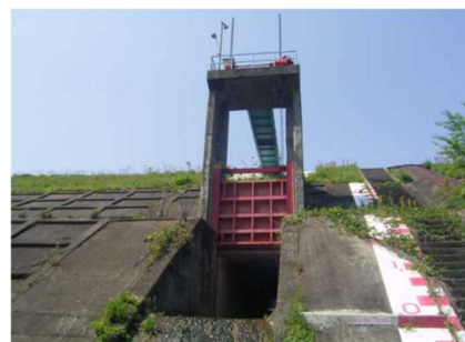
河川管理施設 排水樋門
