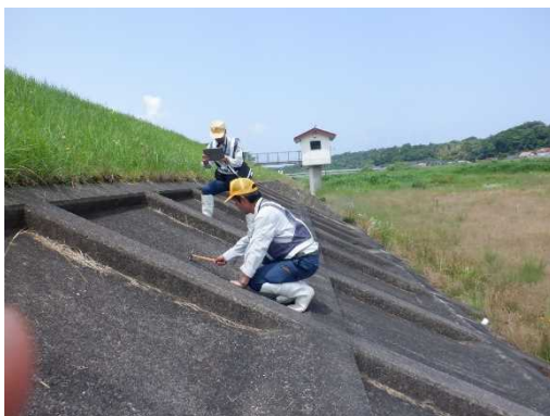
河川管理施設点検状況
