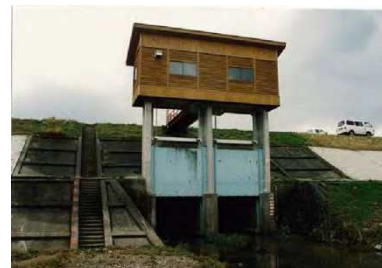
河川管理施設 排水樋門
