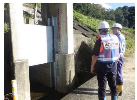
(点検実施状況)
