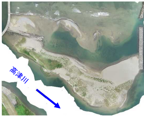
(河口部導流堤上流側の堆積土砂)
