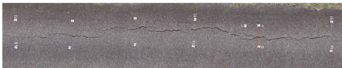
(デジタルカメラを用いた画像解析による変状計測)
