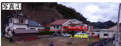
川本第2水源地前の大型土のう端部付近から3.0m程度の盛土
