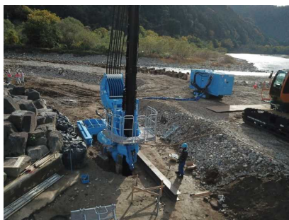
【遮水矢板の打設】
