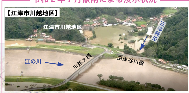
令和2年7月豪雨による浸水状況
