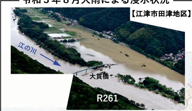
令和3年8月大雨による浸水状況
