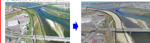
河道掘削事例（高津地区）
