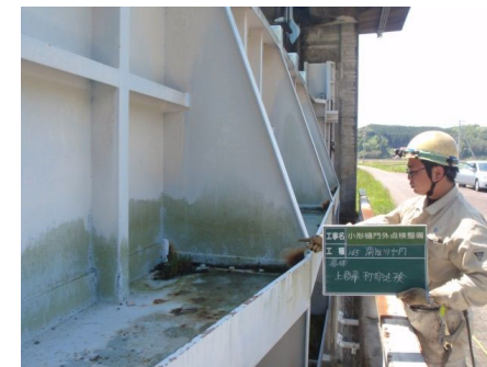
排水門等の点検状況
