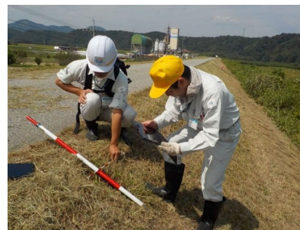
堤防点検状況
