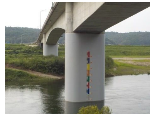
橋梁への量水標の設置
