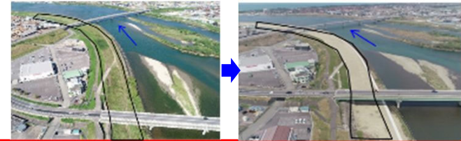
河道掘削事例（高津地区）
