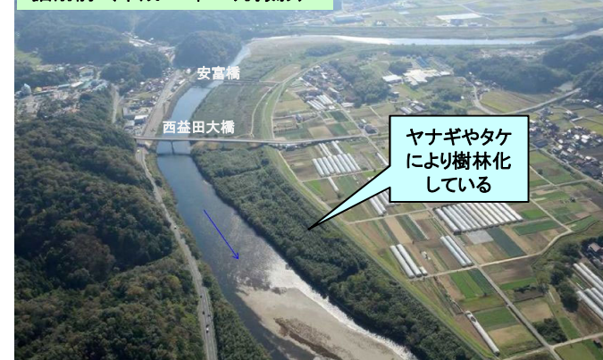
掘削前（平成28年11月撮影）
