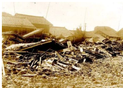
② 昭和18年9月洪水による 益田市街地の被災状況
