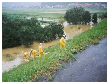
⑥ 平成9年7月洪水による堤防 法尻への水防活動状況
