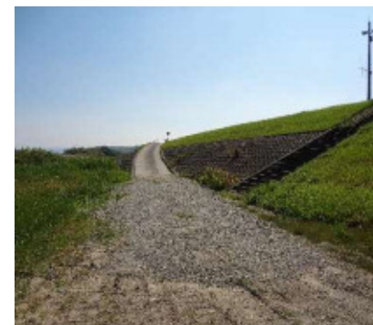
未舗装の通路
