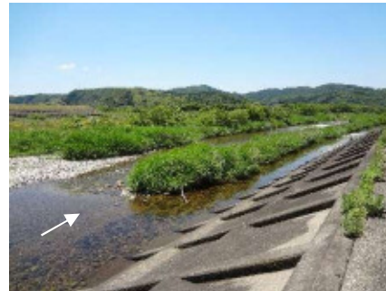
・河原に降りるための幅が狭く急な階段 ・坂路は無い
