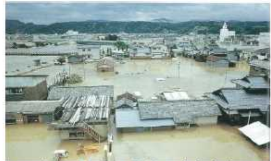
中国電力から県合同庁舎方向 昭和五十八年七月豪雨災害誌
