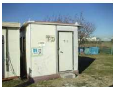
荒川戸田橋サッカー場管理小屋
