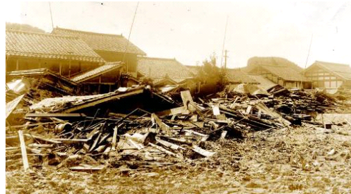
② 昭和18年9月洪水による益田市街地の被災状況
