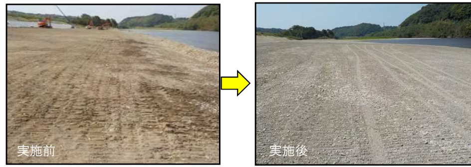
掘削箇所下流についてマルチングを実施
