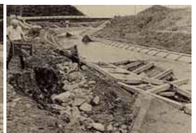
昭和47年7月洪水による 白上川の被災状況
