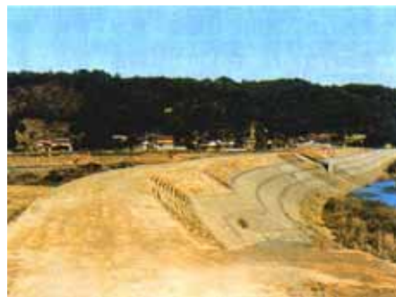
昭和 42 年以降の主な工事 (白上川堤防工事(昭和 55 年))
