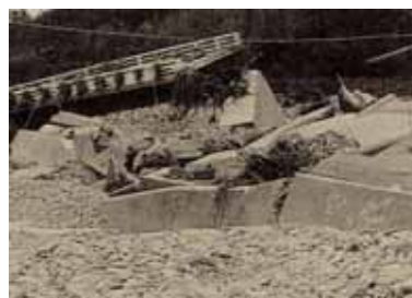
昭和47年7月洪水による 派川虫追橋の被災状況
