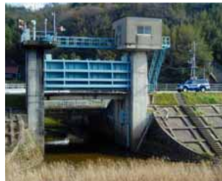
排水門の点検状況
