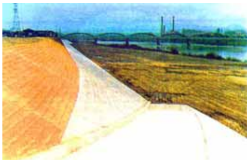
昭和 42 年以降の主な工事 (高津地区護岸工事(昭和 54 年))
