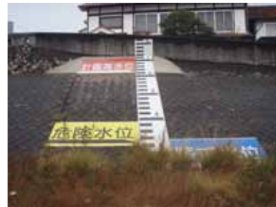
量水標の着色状況
