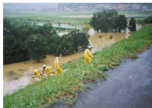
平成 9 年 7 月洪水による漏水状況
