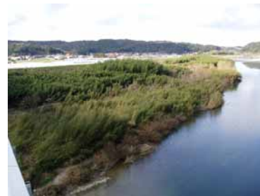
河道内樹木の状況
