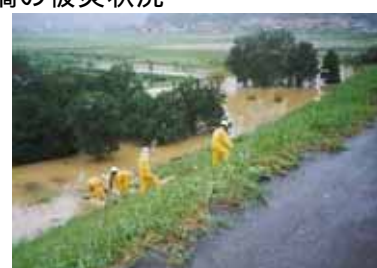
3 平成9年7月洪水による堤防法尻からの 漏水対策のための水防活動状況
