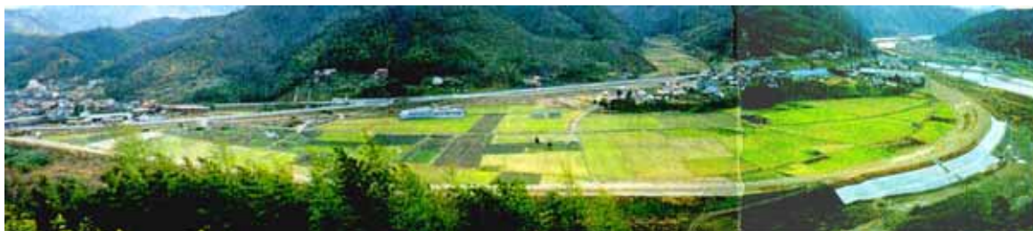
昭和 42 年以降の主な工事 (神田地区引堤工事(昭和 63 年))
