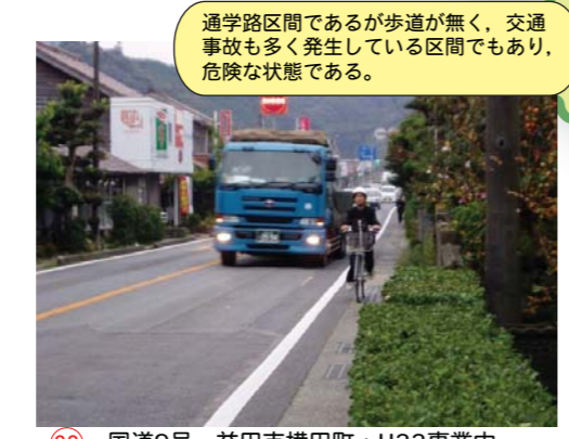
③⑧ 国道9号 益田市横田町：H22事業中
