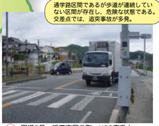
②④ 国道9号 浜田市国分町：H22事業中
