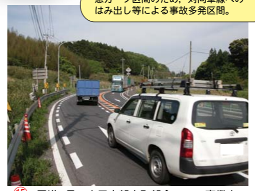
①⑤ 国道9号 大田市朝山町朝倉：H22事業中
