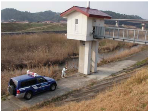
河川管理施設点検状況
