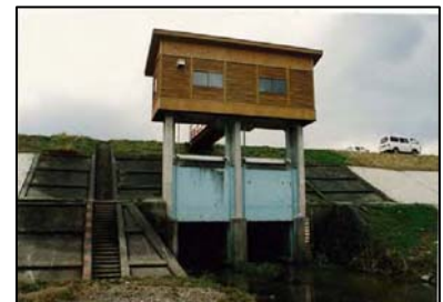
河川管理施設 排水樋門
