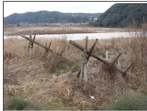
安富地区(高津川 11.2k 右岸付近)
