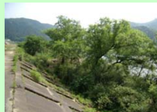
河道内樹木の繁茂状況
