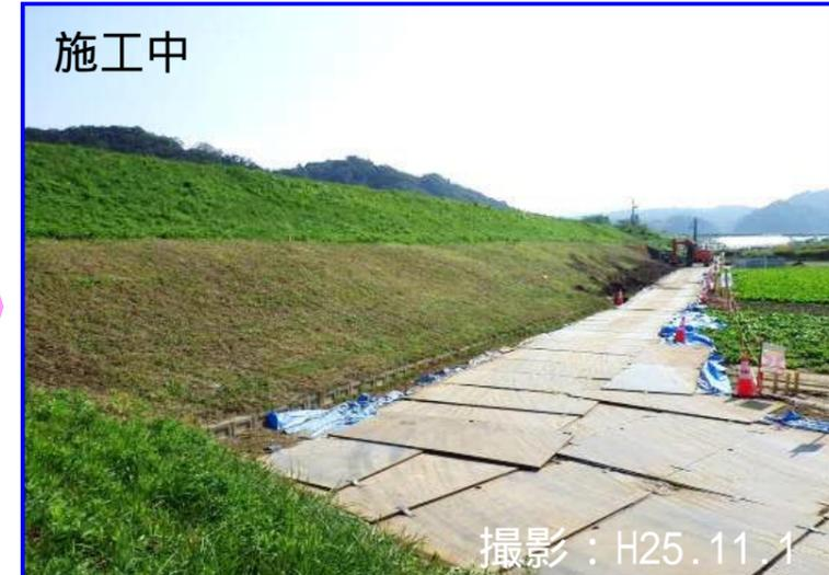
工事に必要な進入路を設置し堤防の法尻にドレーンを施工する為掘削に着手しました
