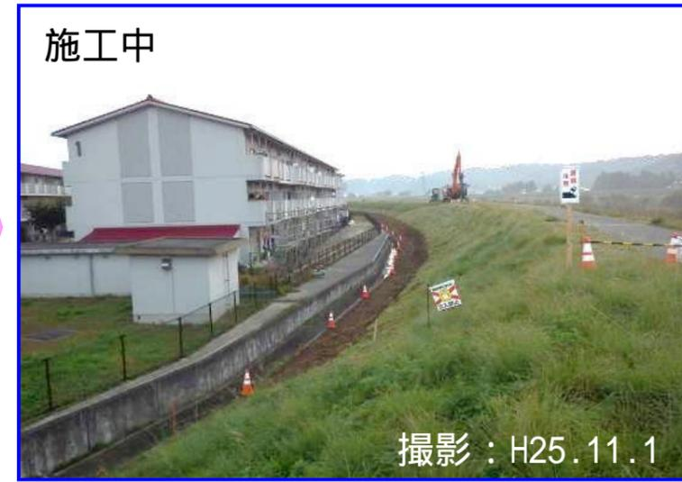
堤防の法尻にドレーンを施工する為掘削を行っています
