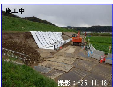
掘削後にフィルター材を敷いて、 割栗石でドレーンを形成しています。 全体350mの内、70mが完了しました。
