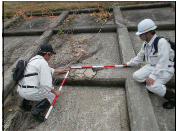
堤防点検状況
