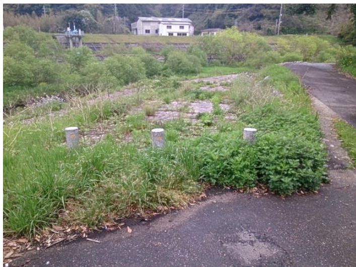
園路の土砂堆積（益田市飯田町）
