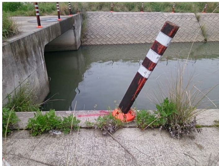
ポストコーン損傷（益田市高津町）
