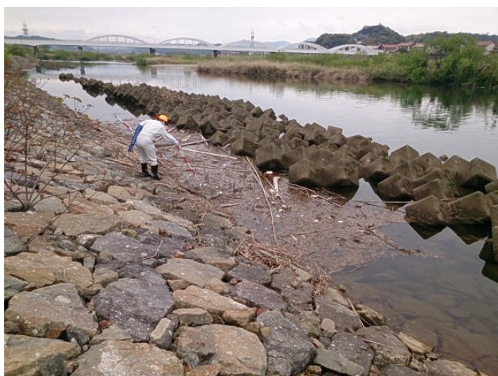
河道内の流木堆積（益田市須子町）
