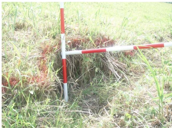
いのししの掘り起こしによる法面損傷
