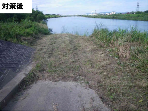
除草を行い見やすくした(益田市飯田町)
