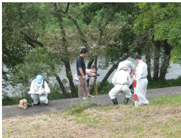
堤防点検状況
