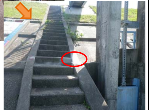
階段護岸の損傷（江津市渡津町）
