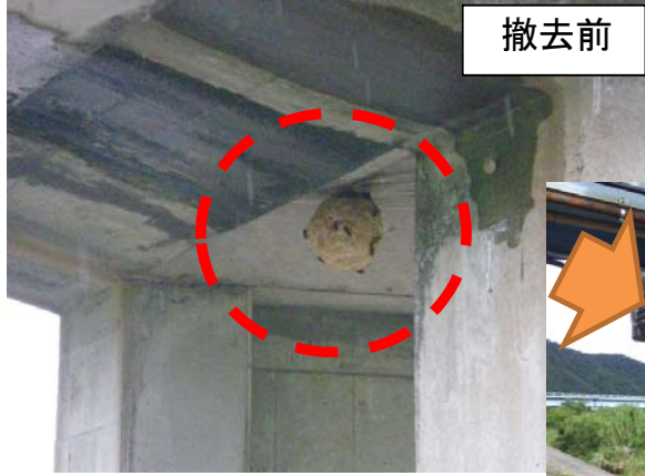
大滝排水樋門 （益田市向横田町）
