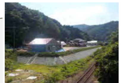
宅地嵩上げ整備箇所(松川橋付近)
