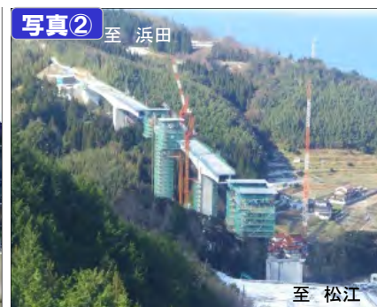
写真② 小田第1高架橋
