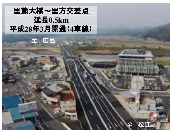
里熊大橋 広島方面を望む
