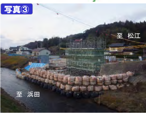
写真③ 仁摩IC橋
