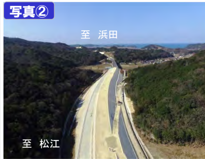
はねがわ 施工状況(羽根川橋付近)
