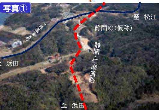
写真① 静間IC(仮称)から東を望む
