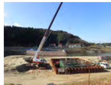
三隅川橋 整備状況
