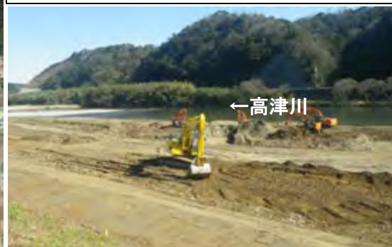
<掘削状況写真>
