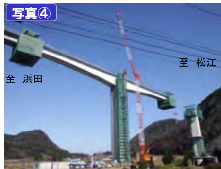
写真④ 口田儀第4高架橋
