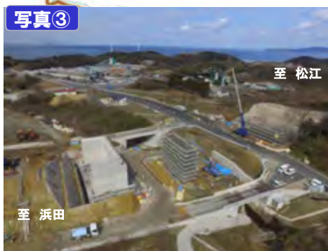
多伎IC(仮称)付近 多伎IC橋
