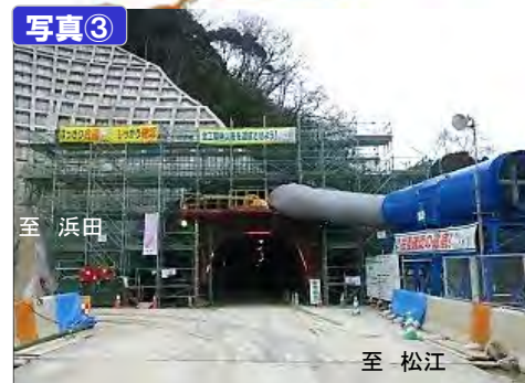
写真③ 口田儀第1トンネル
