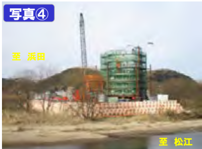
しずまがわ 静間川橋
