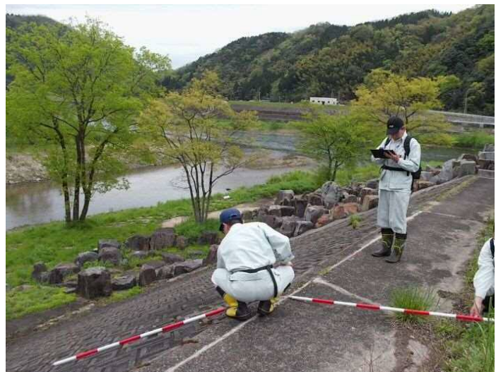
堤防点検状況
