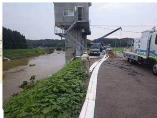
排水ポンプ車設置状況
