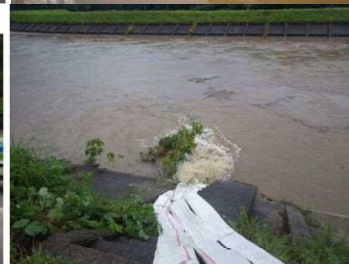
排水ポンプ車作業状況
