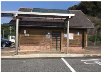
既存トイレ状況
