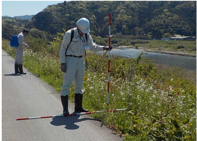
堤防点検状況
