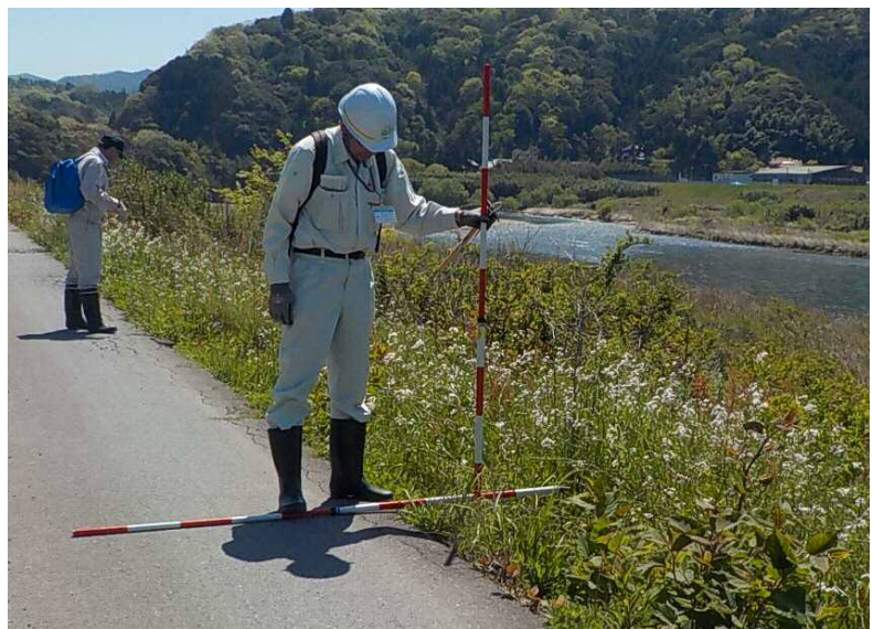
堤防点検状況
