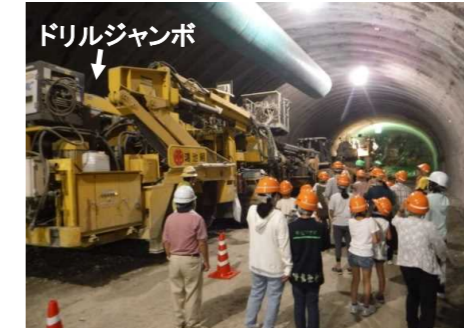
トンネルの坑内で建設機械(ドリルジャンボ)の説明をしています。
