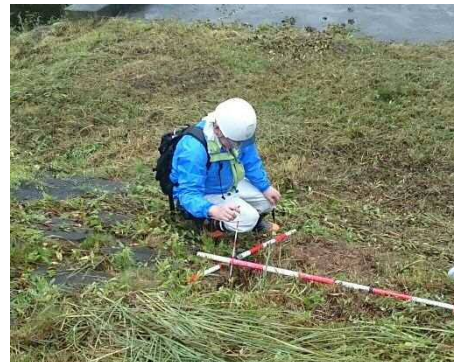
動物等による堤防の掘り返し(益田市虫追町)
