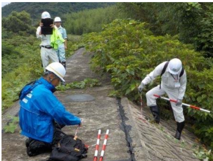
点検状況(江津市金田町)
