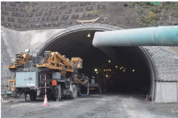
工事現場の状況 (古市場トンネル工事)
